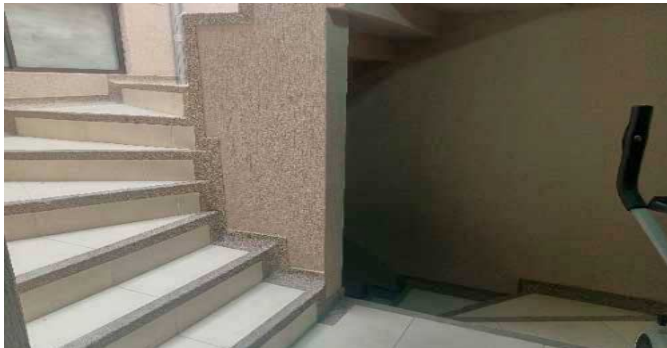
Escalera común - CJ
