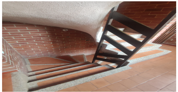
Escalera común - CJ
