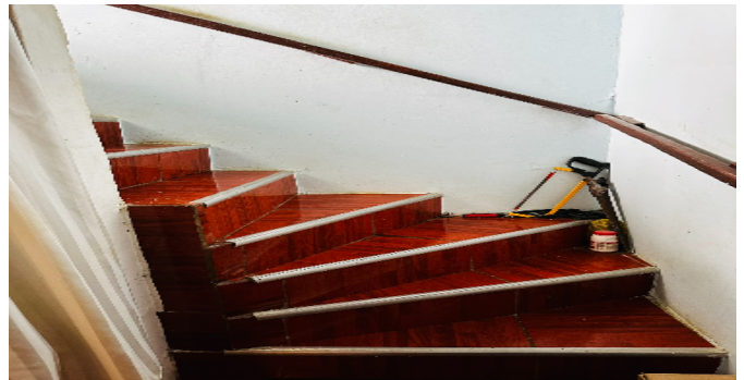
Escalera del inmueble
