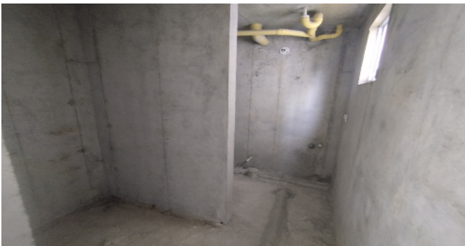
Baño Privado Hab 1
