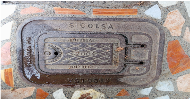
Contador de Agua
