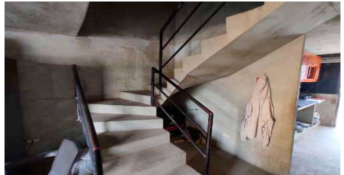
Escalera del inmueble
