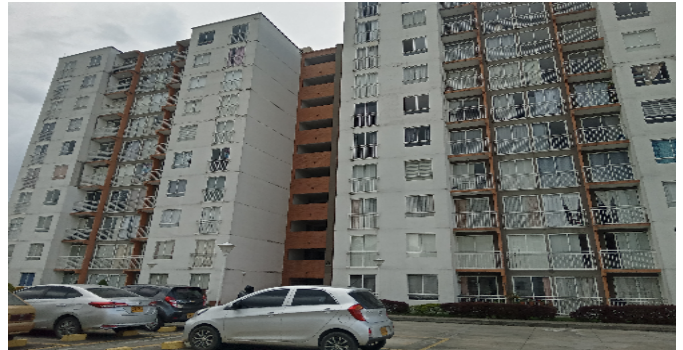
Fachada del Inmueble
