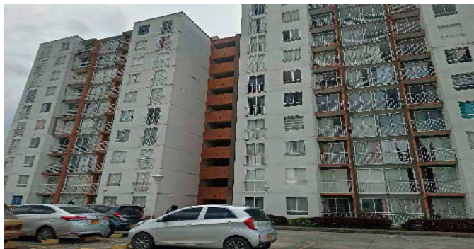
Fachada del Inmueble
