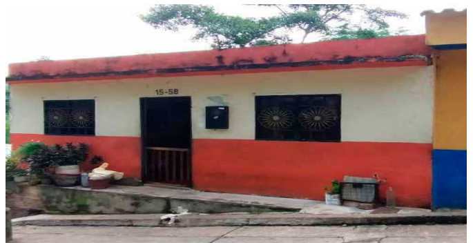
Fachada del Inmueble
