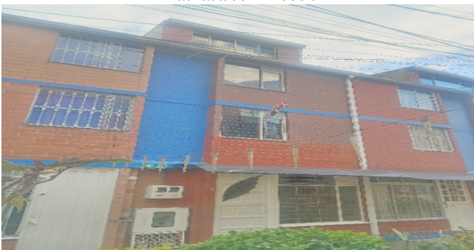
Fachada del Inmueble
