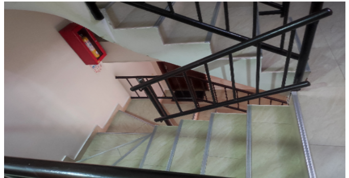
Escalera común - CJ
