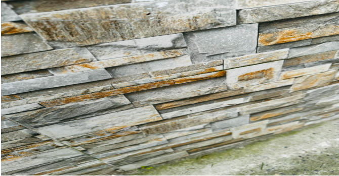
Detalle de acabados
