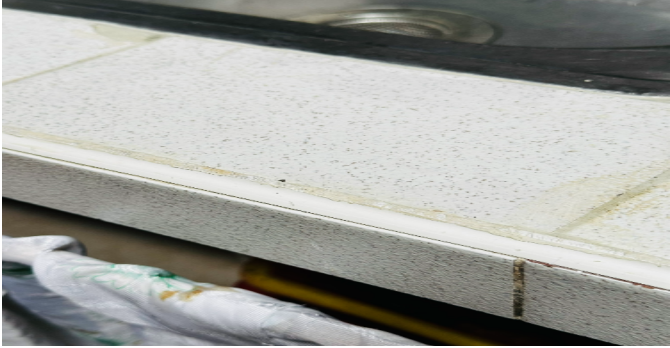
Detalle de acabados
