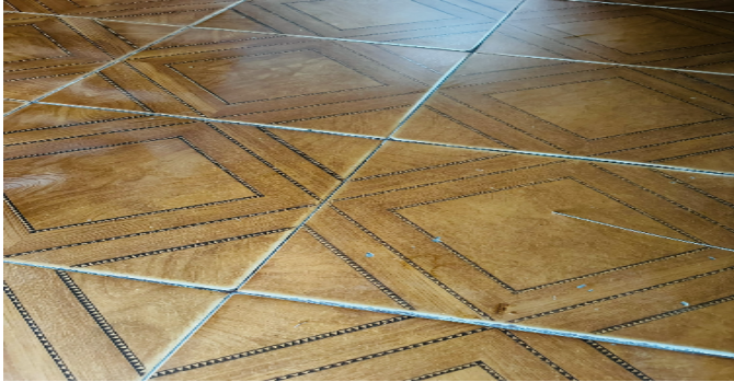
Detalle de acabados
