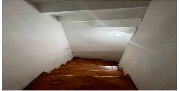
Escalera del inmueble
