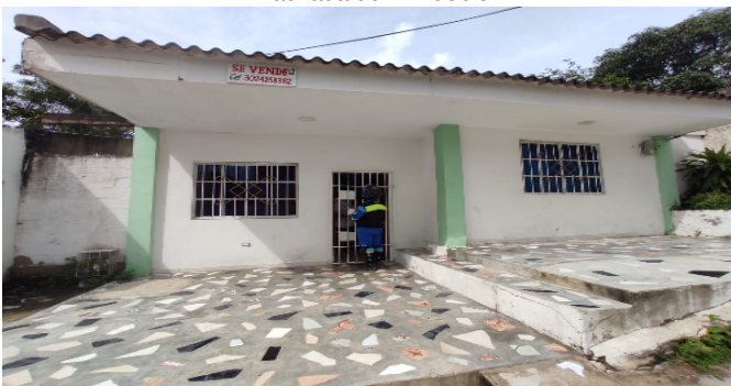
Fachada del Inmueble
