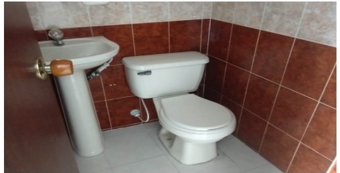
Baño Privado Hab 1
