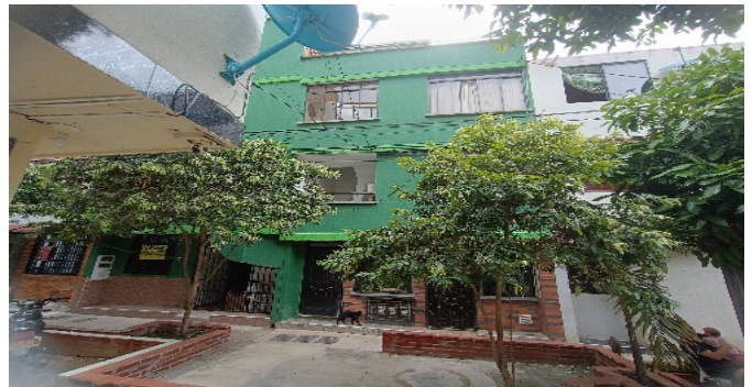
Fachada del Inmueble
