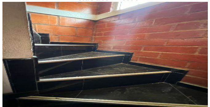
Escalera del inmueble
