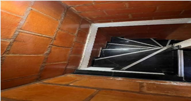
Escalera del inmueble
