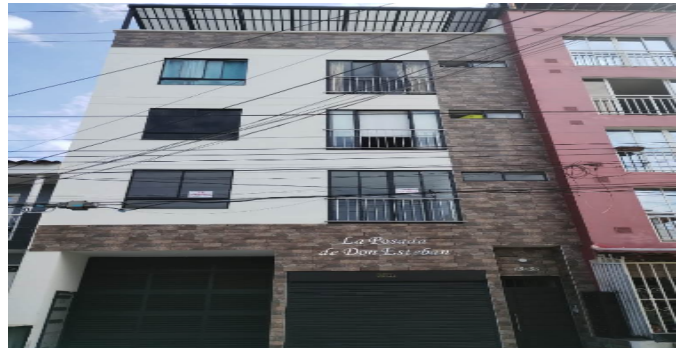
Fachada del Inmueble
