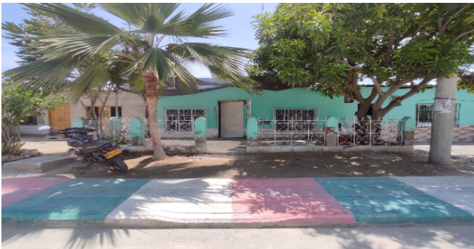
Fachada del Inmueble
