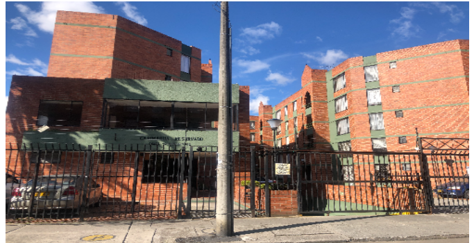
Fachada del Inmueble
