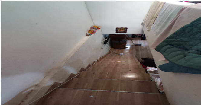
Escalera del inmueble
