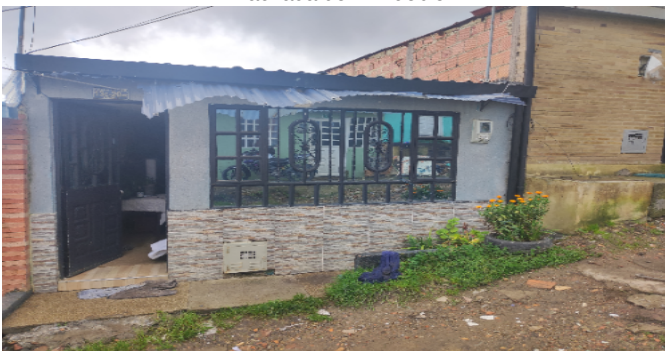
Fachada del Inmueble
