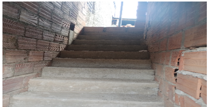
Escalera del inmueble
