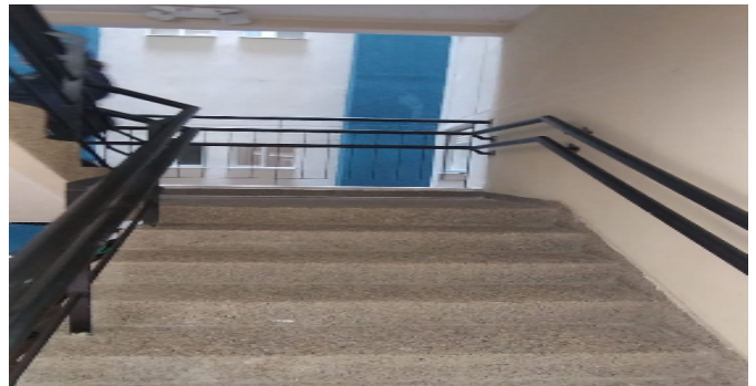
Escalera común - CJ
