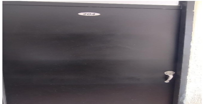
Fachada del Inmueble
