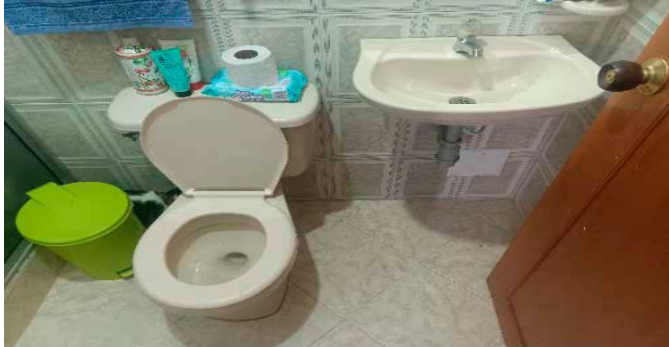
Baño Privado Hab 1
