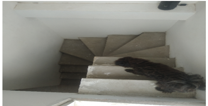
Escalera del inmueble
