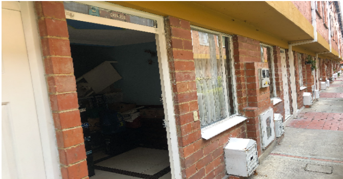
Fachada del Inmueble
