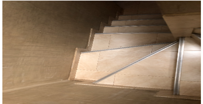
Escalera del inmueble
