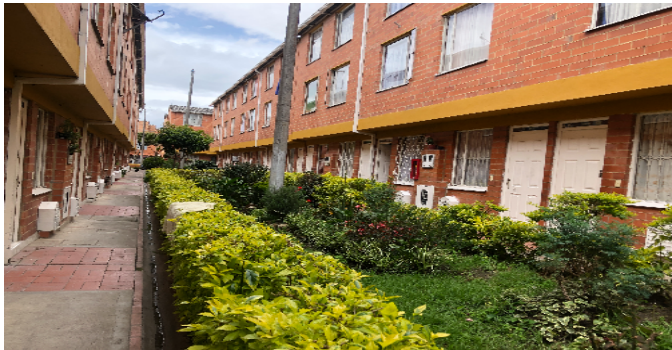
Fachada del Inmueble
