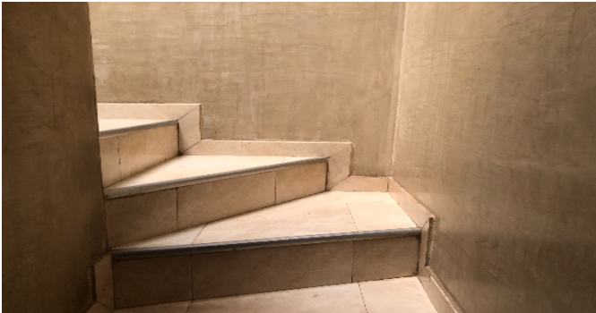
Escalera del inmueble
