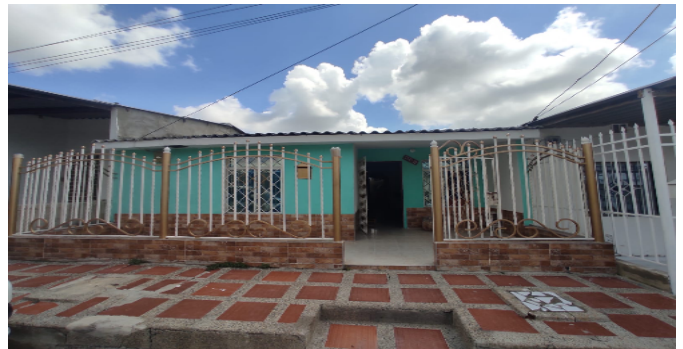
Fachada del Inmueble
