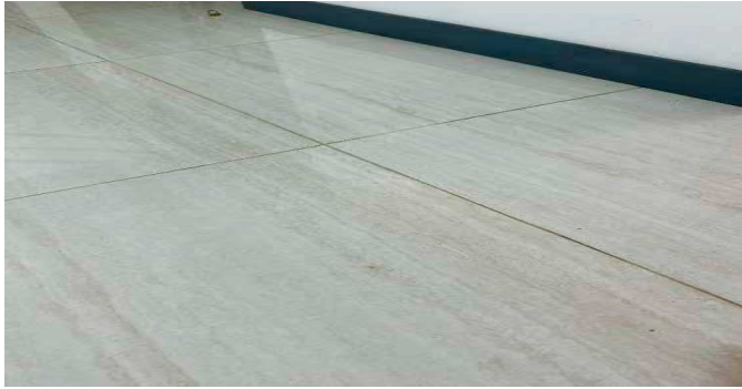
Detalle de acabados
