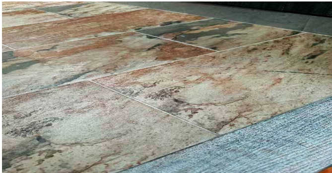
Detalle de acabados
