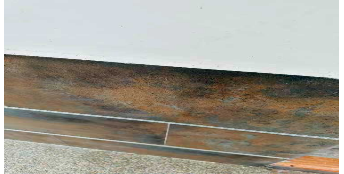
Detalle de acabados
