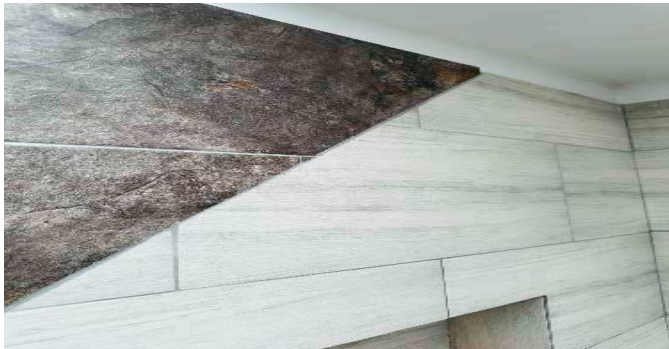
Detalle de acabados
