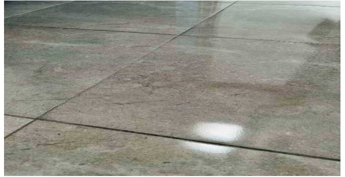
Detalle de acabados
