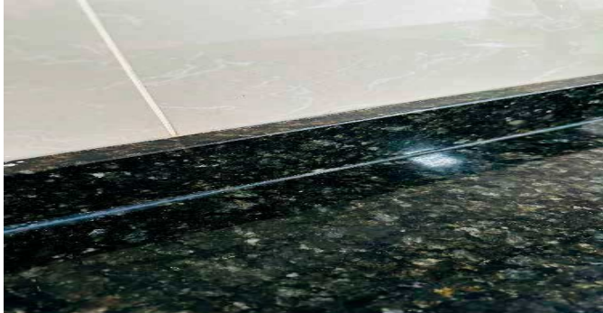
Detalle de acabados
