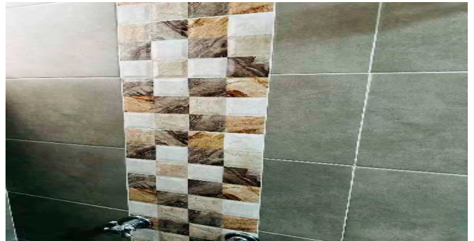
Detalle de acabados
