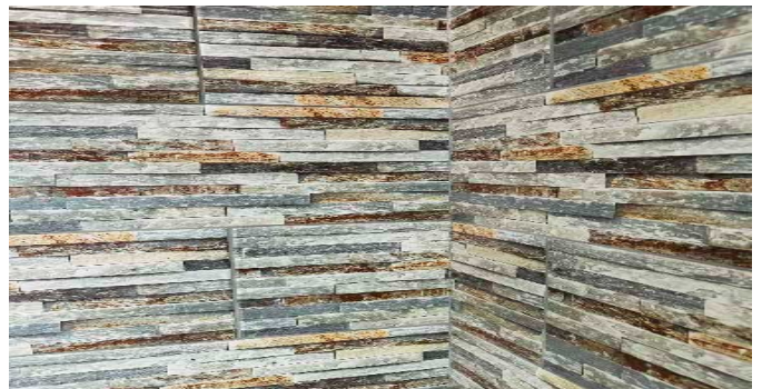
Detalle de acabados
