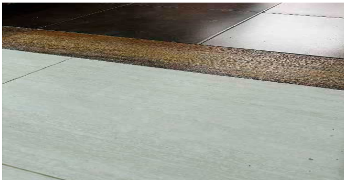
Detalle de acabados
