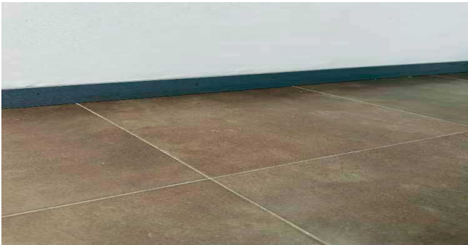
Detalle de acabados
