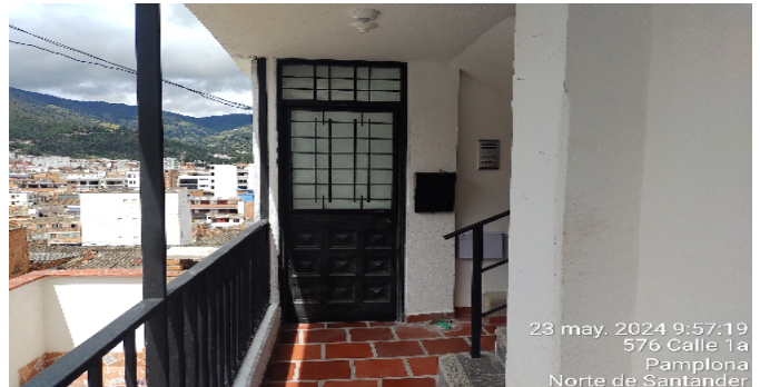
Fachada del Inmueble
