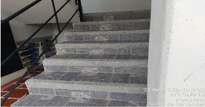
Escalera común - CJ
