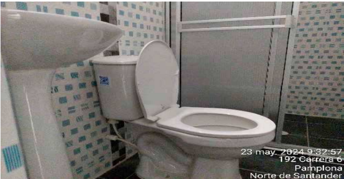
Baño Privado Hab 1
