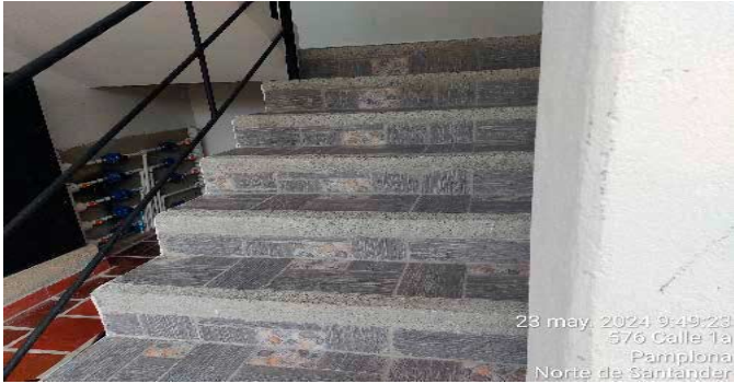
Escalera común - CJ
