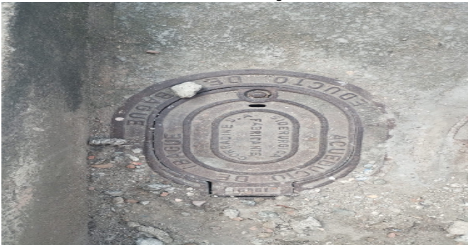
Contador de Agua
