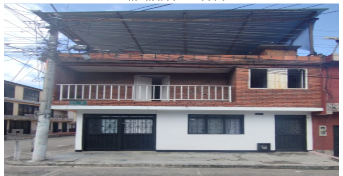
Fachada del Inmueble
