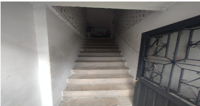
Escalera del inmueble
