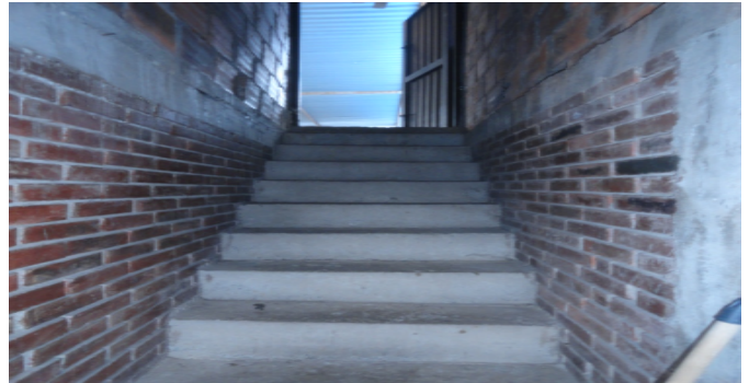
Escalera del inmueble
