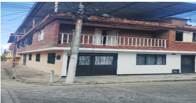
Fachada del Inmueble
