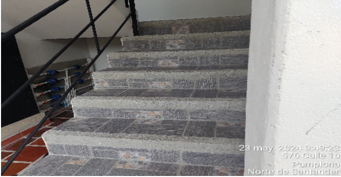
Escalera común - CJ
