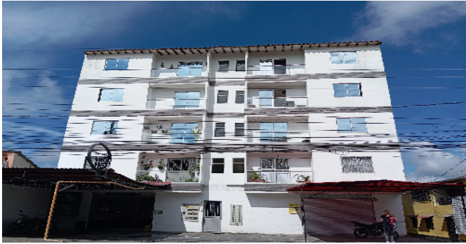
Fachada del Inmueble
