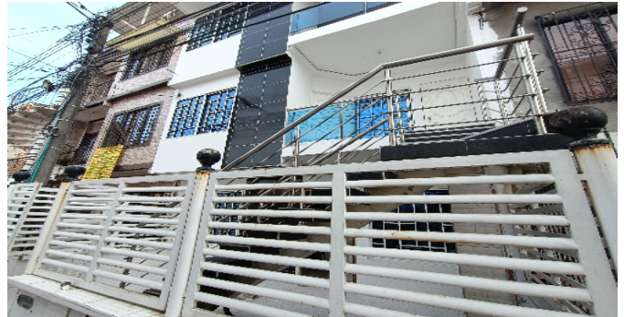
Fachada del Inmueble
