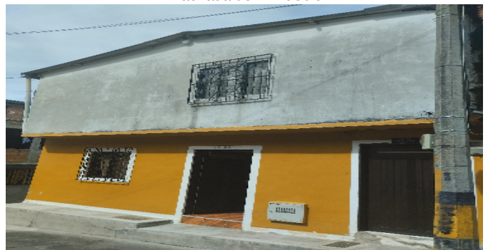
Fachada del Inmueble
