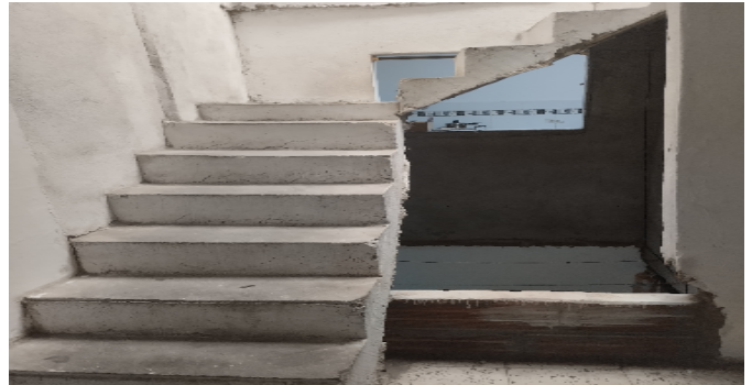
Escalera del inmueble
