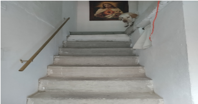
Escalera del inmueble
