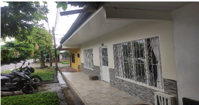
Fachada del Inmueble
