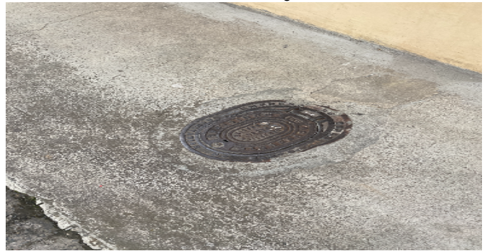
Contador de Agua
