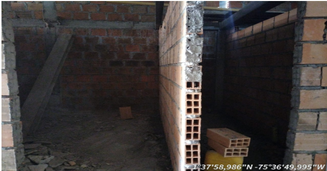
MUROS 2DO PISO
