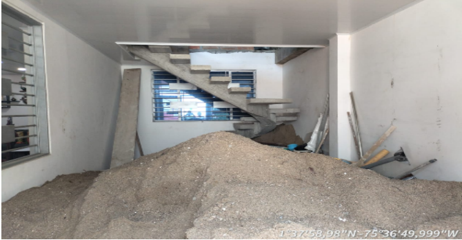
ESCALERAS ACCESO 2DO PISO
