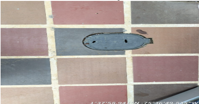
Contador de Agua
