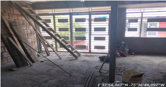
VISTA 2DO PISO
