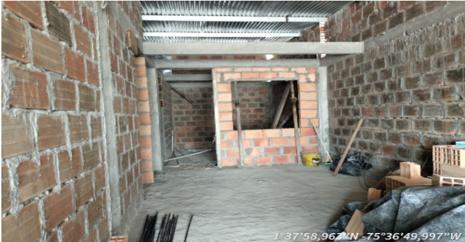
VISTA SEGUNDO PISO
