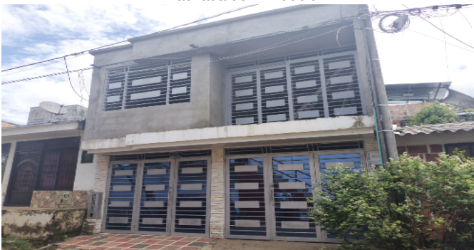
Fachada del Inmueble
