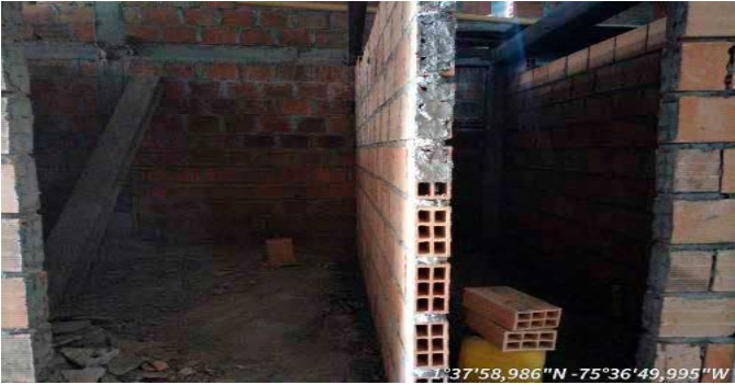
MUROS 2DO PISO
