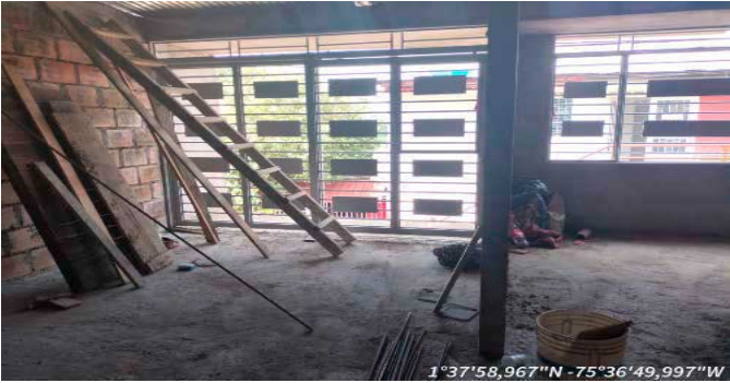
VISTA 2DO PISO
