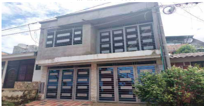
Fachada del Inmueble
