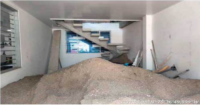
ESCALERAS ACCESO 2DO PISO
