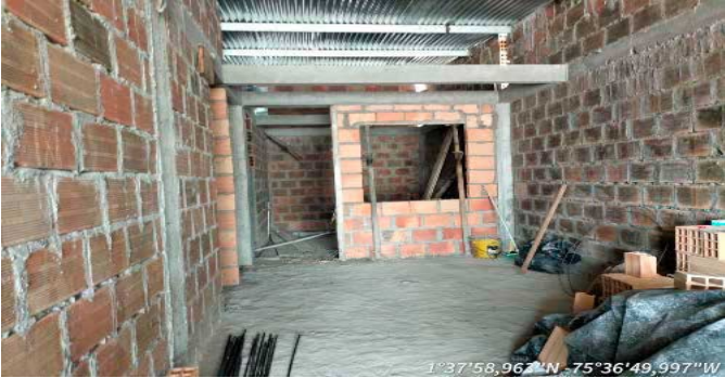
VISTA SEGUNDO PISO
