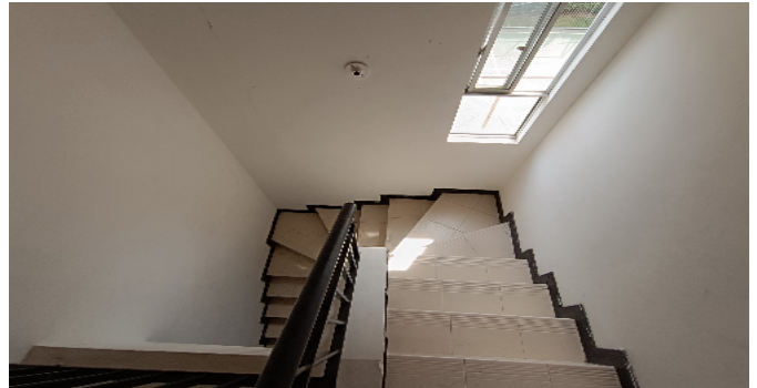
Escalera del inmueble
