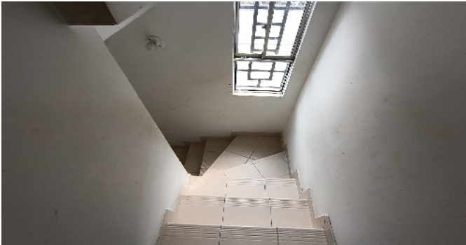
Escalera del inmueble
