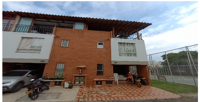
Fachada del Inmueble
