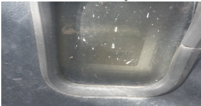
Contador de Energia
