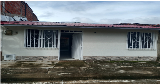
Fachada del Inmueble
