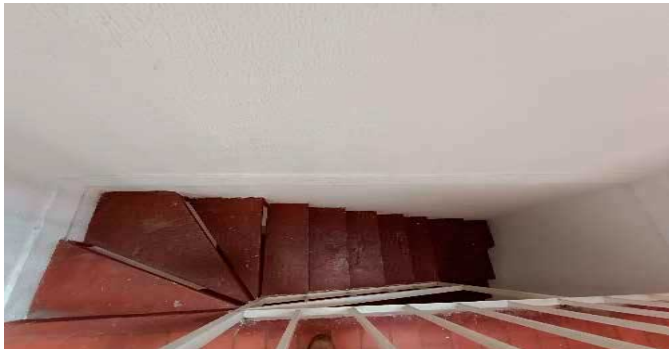
Escalera del inmueble
