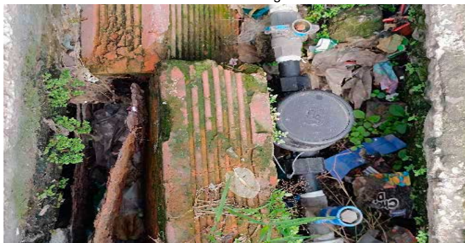
Contador de Agua
