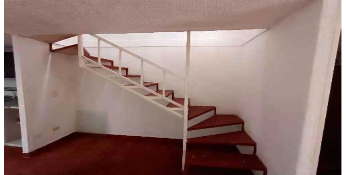
Escalera del inmueble
