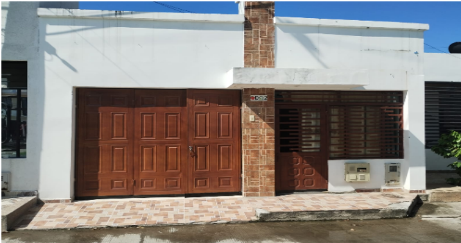
Fachada del Inmueble
