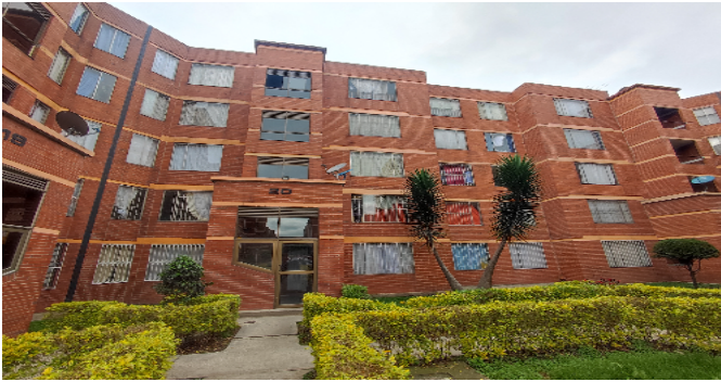
Fachada del Inmueble
