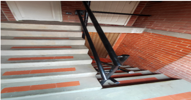
Escalera común - CJ
