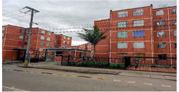
Fachada del Inmueble
