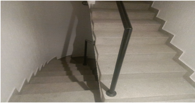
Escalera común - CJ
