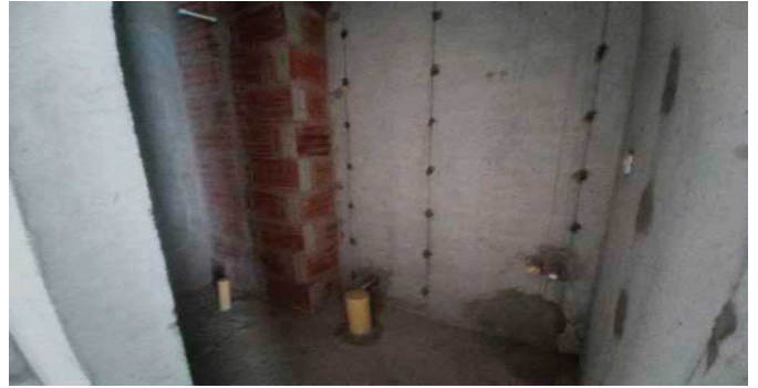
Baño Privado Hab 1
