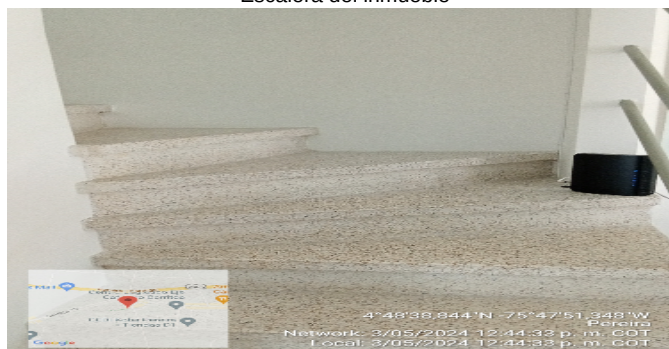
Escalera del inmueble
