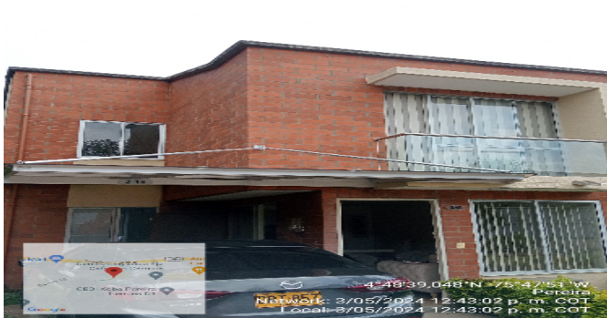
Fachada del Inmueble
